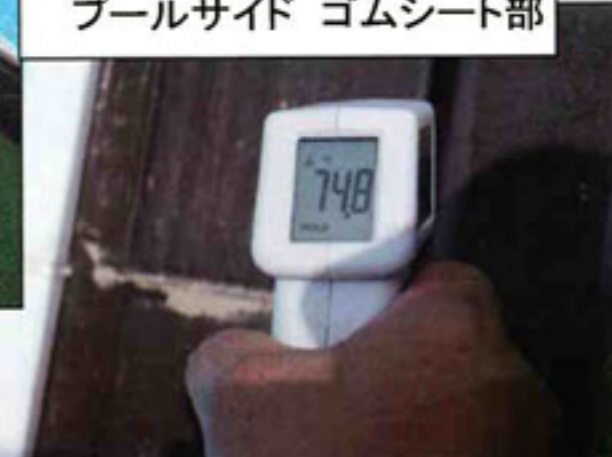
未塗装 プールサイド ゴムシート部
