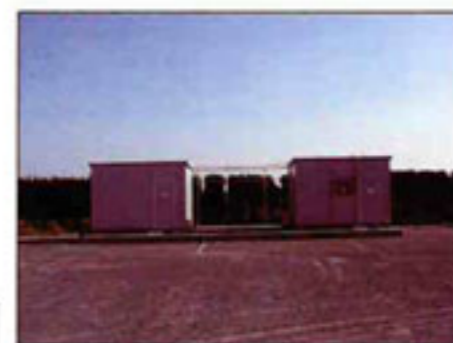
電力積算計、電力記録計を東棟、西棟に取り付け、電力量を記録。
